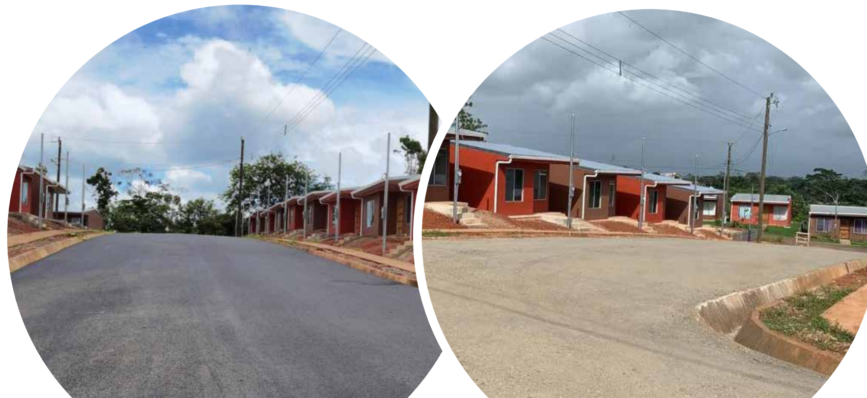
Residencial Las Rosas de Pocosol. II Etapa-Calle pública asfaltada
